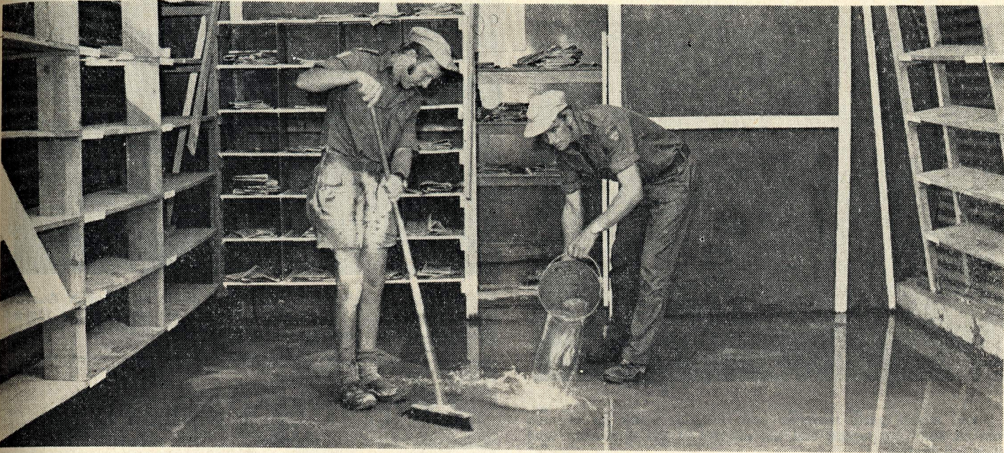
Fu Ingert Svensson och Barne Svanberg vattnar det nya golvet i biblioteket.
