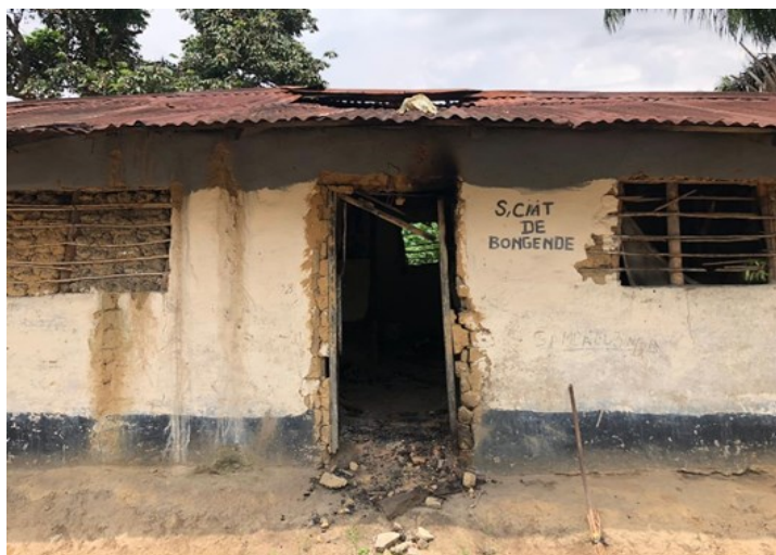
13: Sous-commissariat de Bongende incendié au cours de l'attaque BCNUDH-
