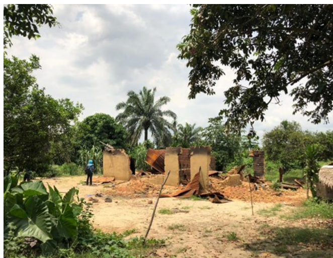
14: Maison détruite par incendie BCNUDH-
