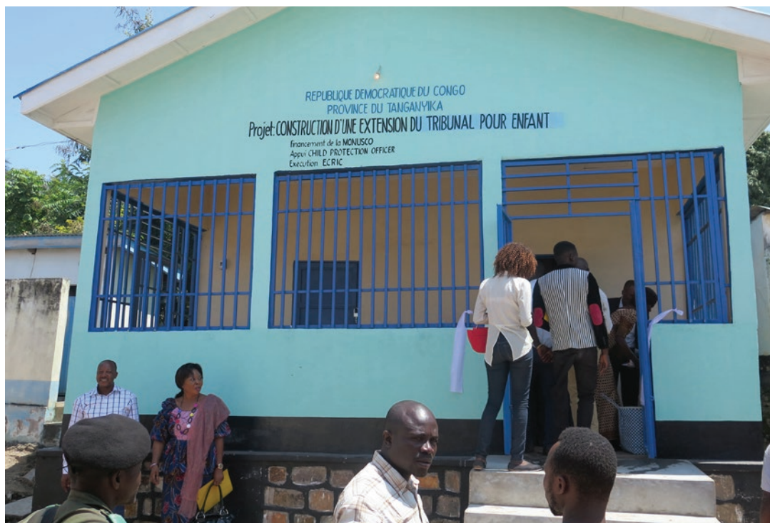
La façade du tribunal pour enfants de Kalemie construit par la MONUSCO
