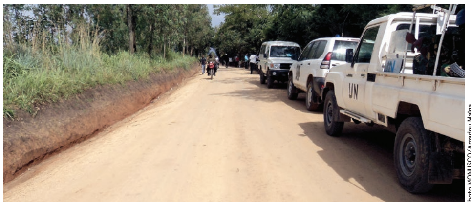
Le tronçon routier Pimbo-Gina, après sa réhabilitation
