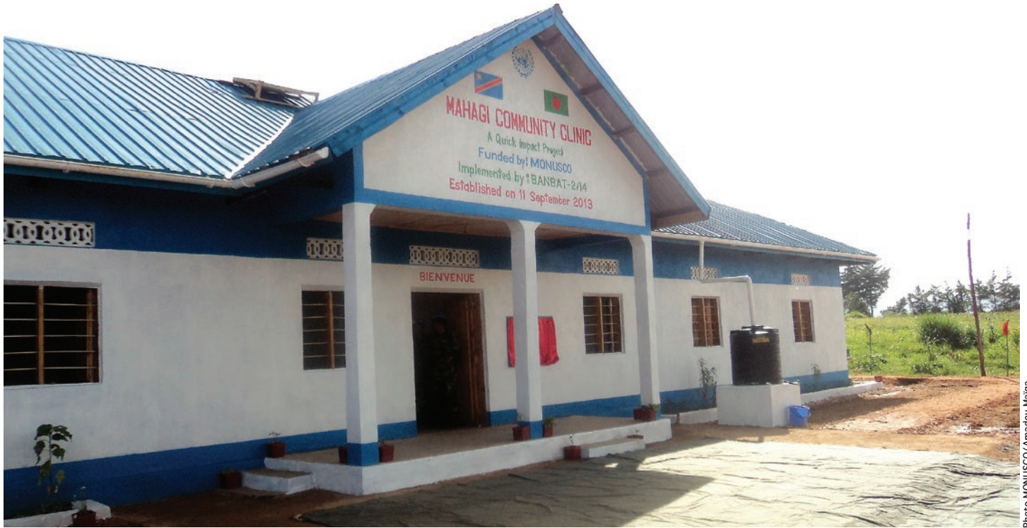
Un des bâtiments de la clinique de Mahagi construits par la MONUSCO en Ituri
