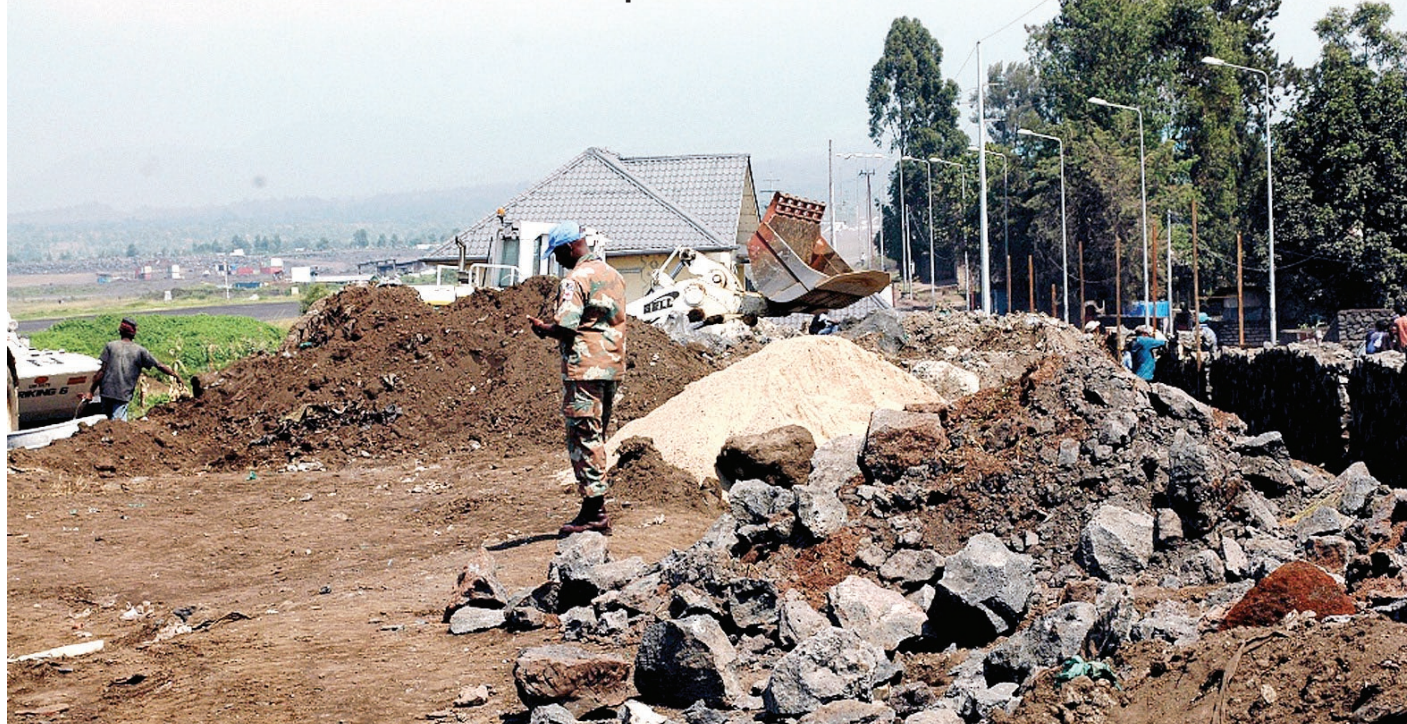
Les travaux de construction d'une enceinte autour de l'aéroport de Goma - Photo MONUSCO/Clara Padovan
