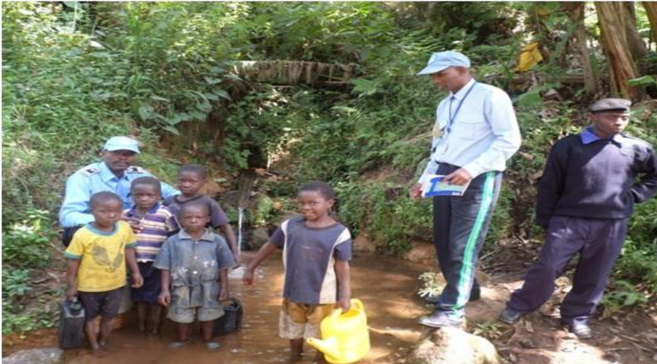
Réparation d'une pompe d'adduction d'eau potable par projet QIPs sur recommandations UNPOL
