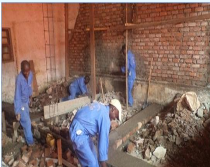
Réhabilitation Bureaux PIC/BUKAVU sur recommandation UNPOL
