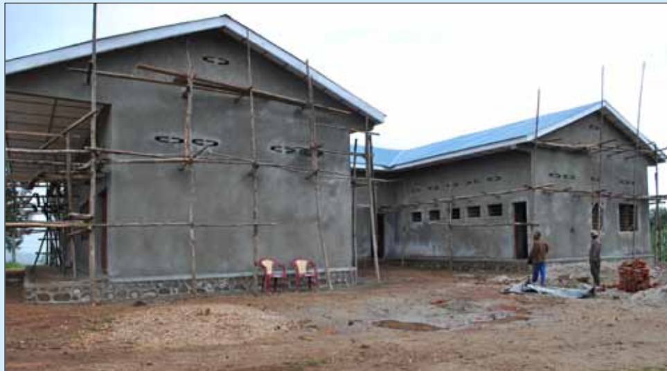
Travaux de construction du Tribunal de Paix à Walungu (Photo : Celcom STAREC)
