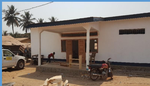
Construction du poste de Police à BOEING, dans la commune de Bimbo
