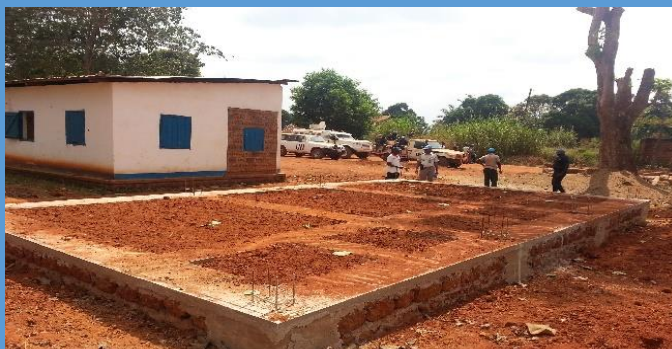
Construction des cellules de détention du Commissariat de Bangassou
